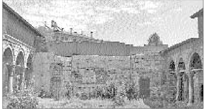
Burüciye Medresesi'nin ön cephesi ile Cökmedrese'nin avlusundan bir görünüş
